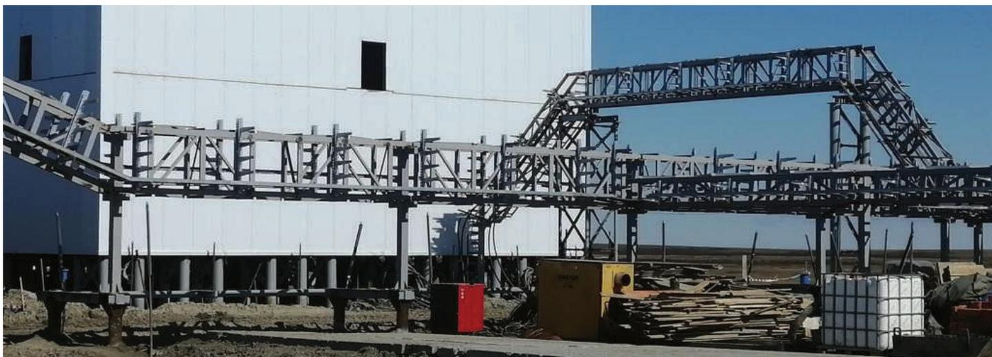
Балочные переходы – эстакады трубопроводов. Представляют пространственную конструкцию, состоящую из параллельно расположенных двутавровых балок или ферм, соединенных между собой горизонтальными связями. Монтируются на стойки из металлических труб диаметров 219,325мм.
